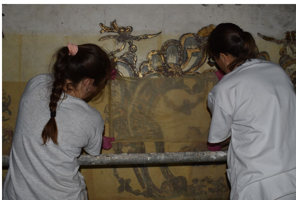
Figura 2. Aplicación de la retorta. Arranque de las pinturas murales de una de las capillas de la Iglesia de los Santos Juanes de Valencia.
