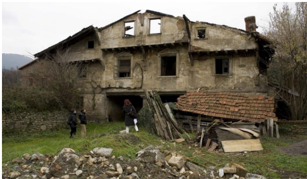
Figura 1. Caserío de Etxebarri tras el incendio de 2009.
