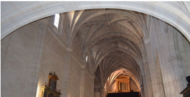
Figura 2. Bóvedas de nave central, crucero y ábside antes de la obra.
